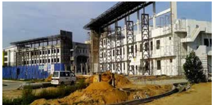
Pandangan hadapan bangunan
