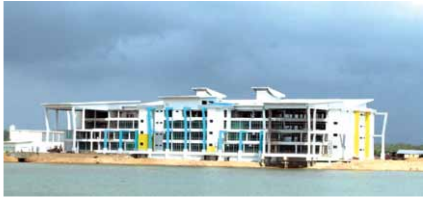
Gambar bangunan Perpustakaan Kampus Pekan yang sedang dalam pembinaan.
