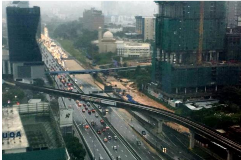
Figure 1.1 Flash flood in Bangsar, Kuala Lumpur (BERNAMA, 2017)
