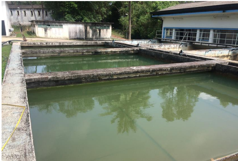
Figure 4.21 Bukit Ubi WTP
