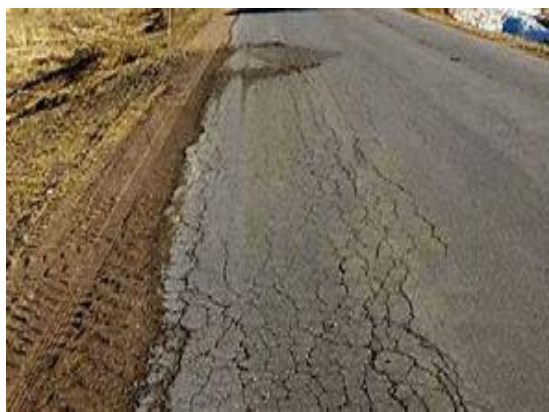
Figure 7 : Edge Cracking
