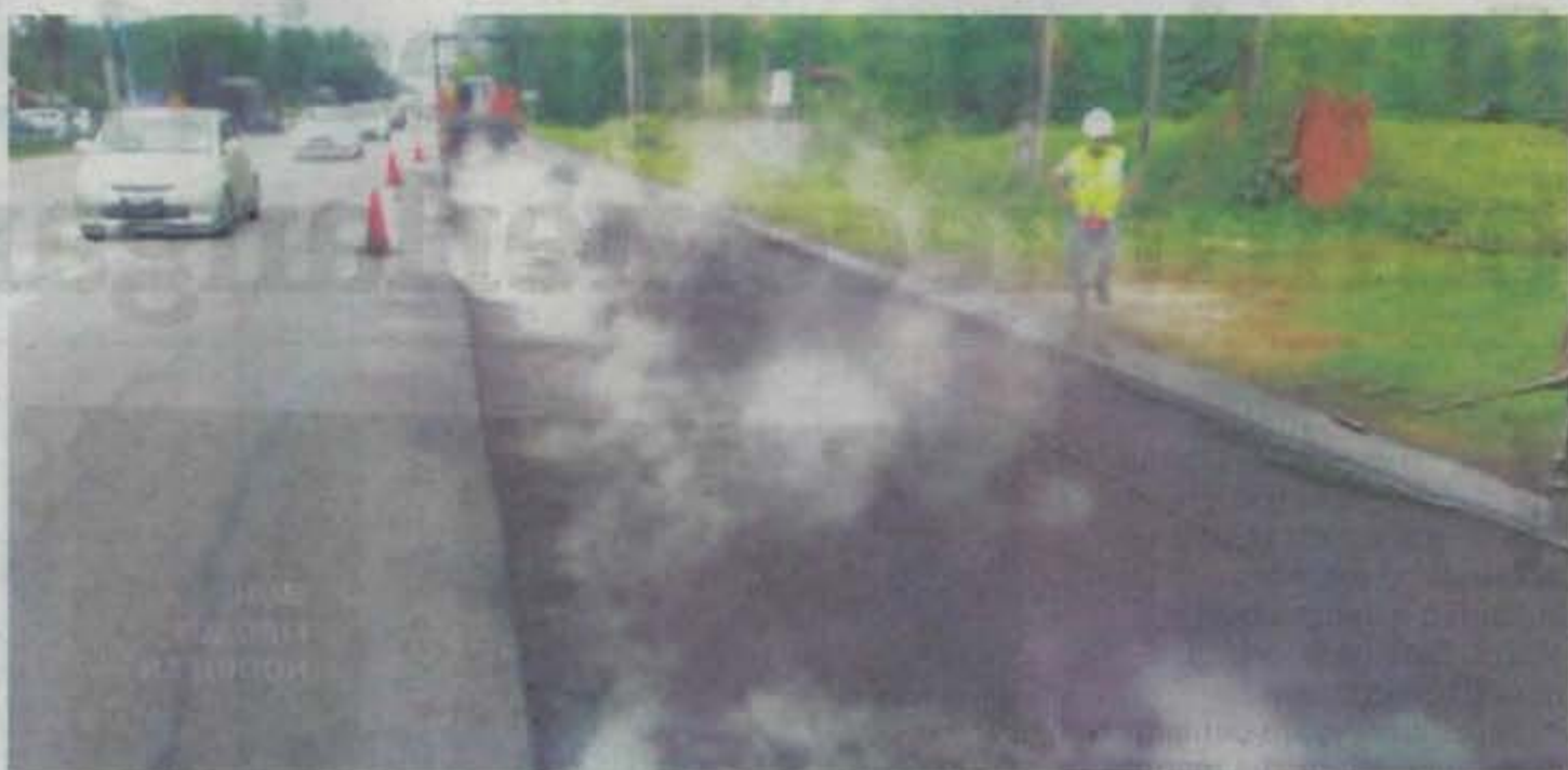
AKTIVITI penyelenggaraan dan penurapan semula permukaan jalan raya utama.
