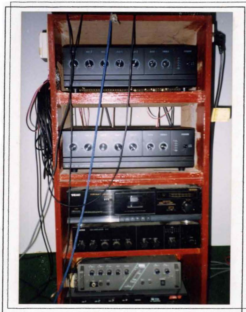
Foto M : TOA PA Amplifier Model A-121M yang digunakan di Masjid Intan Abu Bakar, Sri Pulai.
