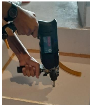
(d) Drilling the hole to insert pipe
