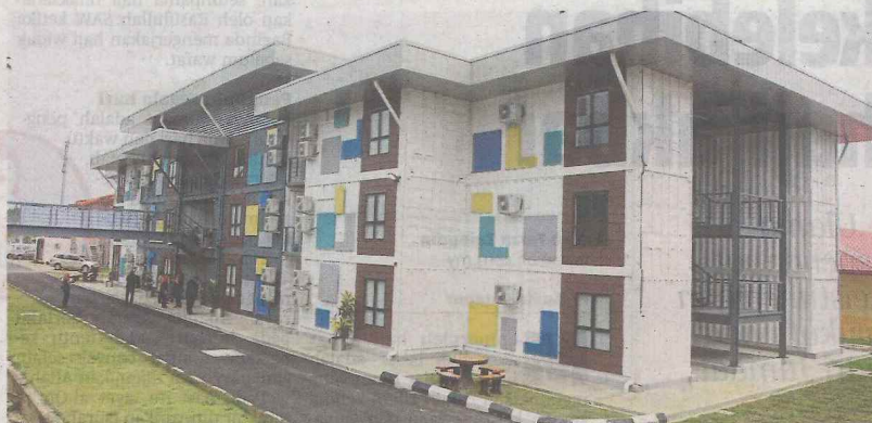
Projek perintis Modular Craft menggunakan kontena terpakai bina 72 unit bilik pensyarah di Kampus UMP Gambang.
